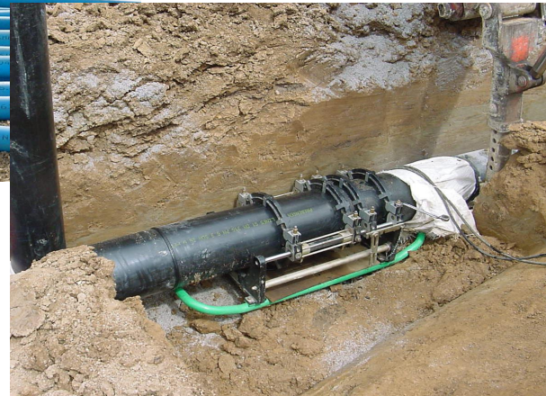
Butt-welding & data logging PE pipe
